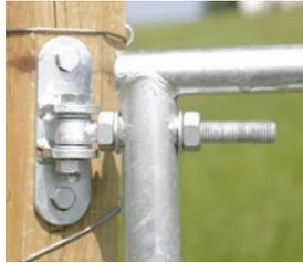
l'ajustement des charnières peut être compensé par le réglage des boulons de charnières !
